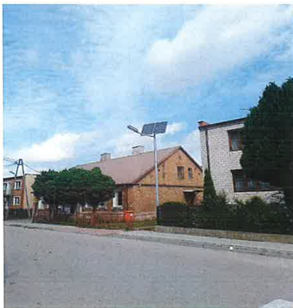
Budowa oświetlenia LED w sołectwie Łęg Probostwo
