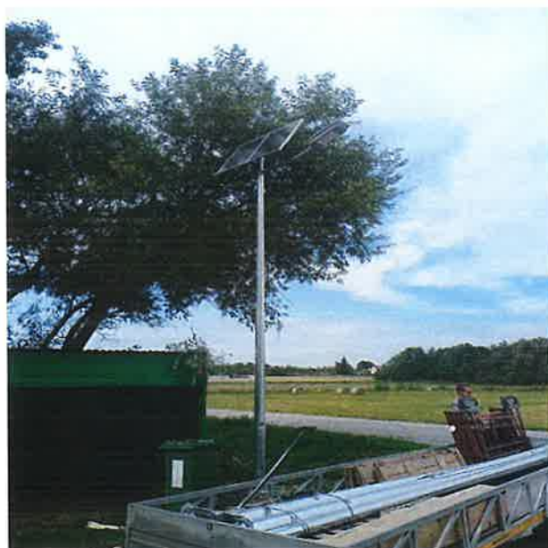
Budowa oświetlenia LED w sołectwie Wrogocin
