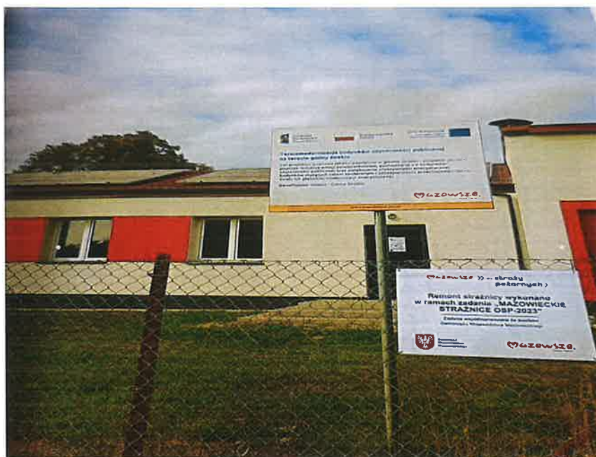
Prace remontowe w OSP Chudzyń
