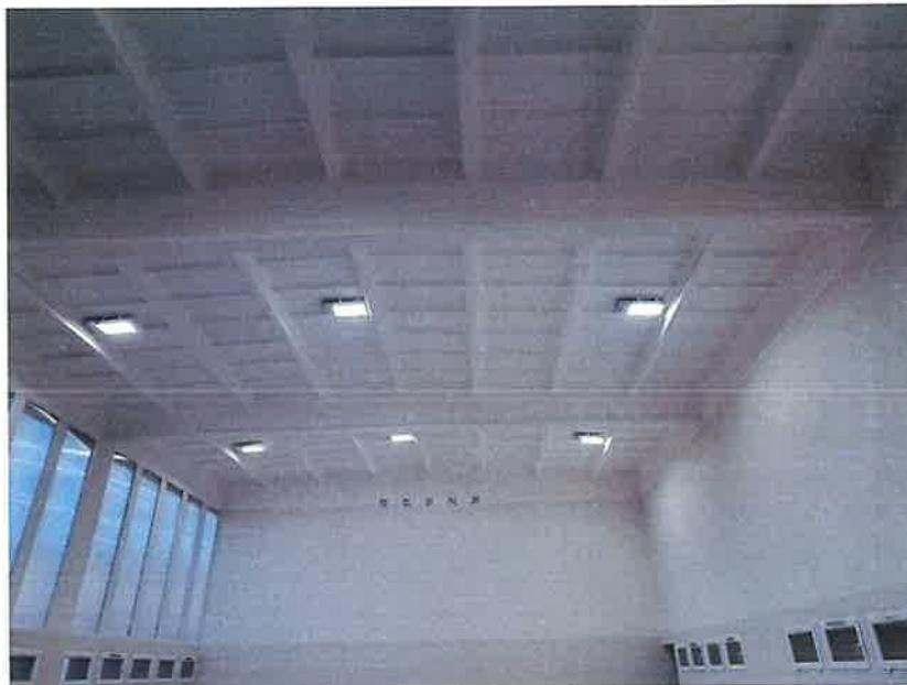
Remont sali gimnastycznej w Drobinie
