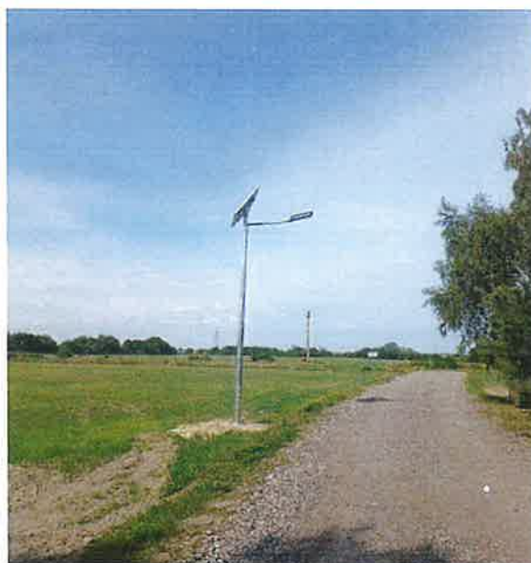
Zakup i montaż 3 lamp LED w sołectwie Borowo
