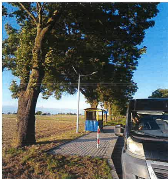
Budowa oświetlenia LED w sołectwie Budkowo
