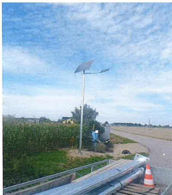
Zakup i montaż 3-ch lamp LED w sołectwie Maliszewko
