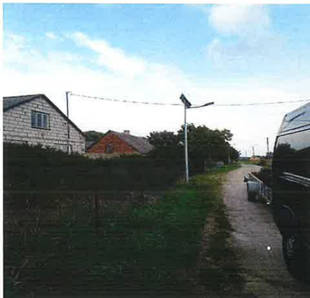
Zakup i montaż 2 szt. lamp LED w sołectwie Siemki
