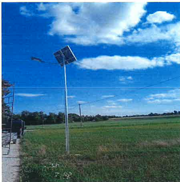
Budowa oświetlenia LED w sołectwie Małachowo
