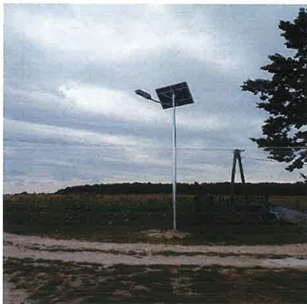
Zakup i montaż 2 lamp w technologii LED w sołectwie Świerczynek I
