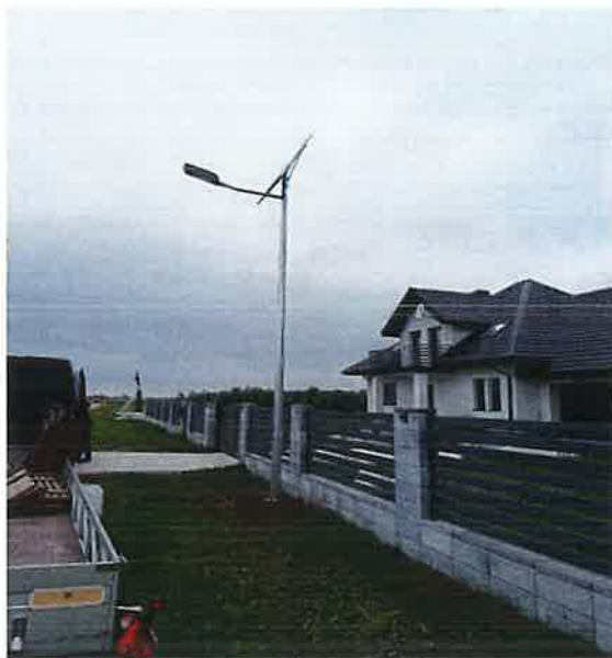
Budowa oświetlenia LED w sołectwie Kozłówko
