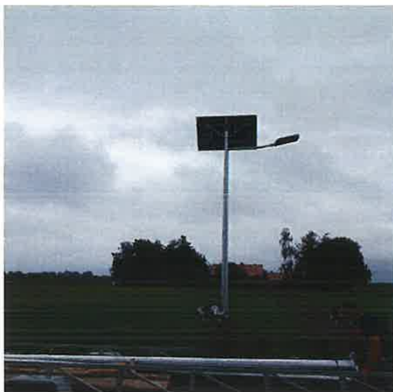
Zakup i montaż 3 lamp w systemie LED w sołectwie Tupadły
