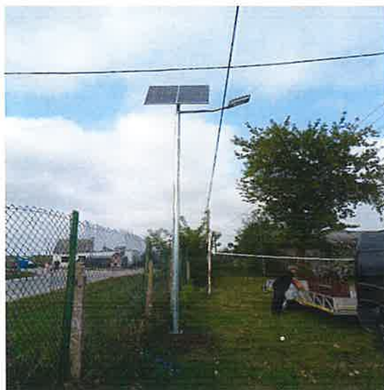
Budowa oświetlenia LED w sołectwie Brzechowo
