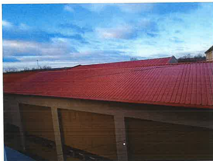
Remont sali gimnastycznej w Drobinie
