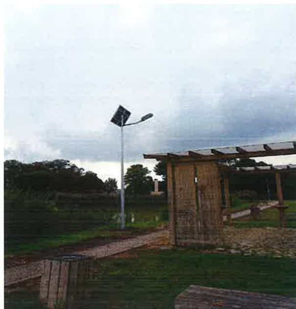
Budowa oświetlenia LED w Drobinie
