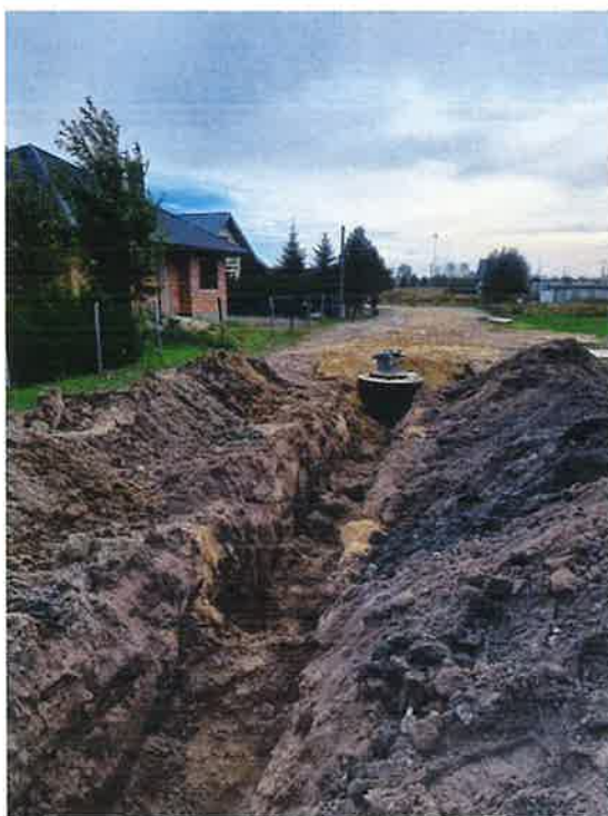
Budowa sieci kanalizacyjnej w Drobinie
