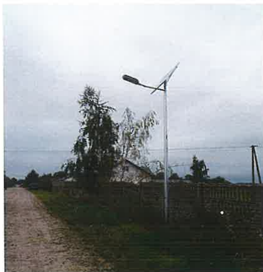
Budowa oświetlenia LED w sołectwie Mokrzk
