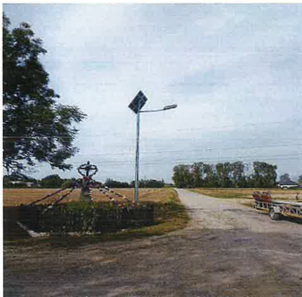
Budowa oświetlenia LED w sołectwie Stanisławowo
